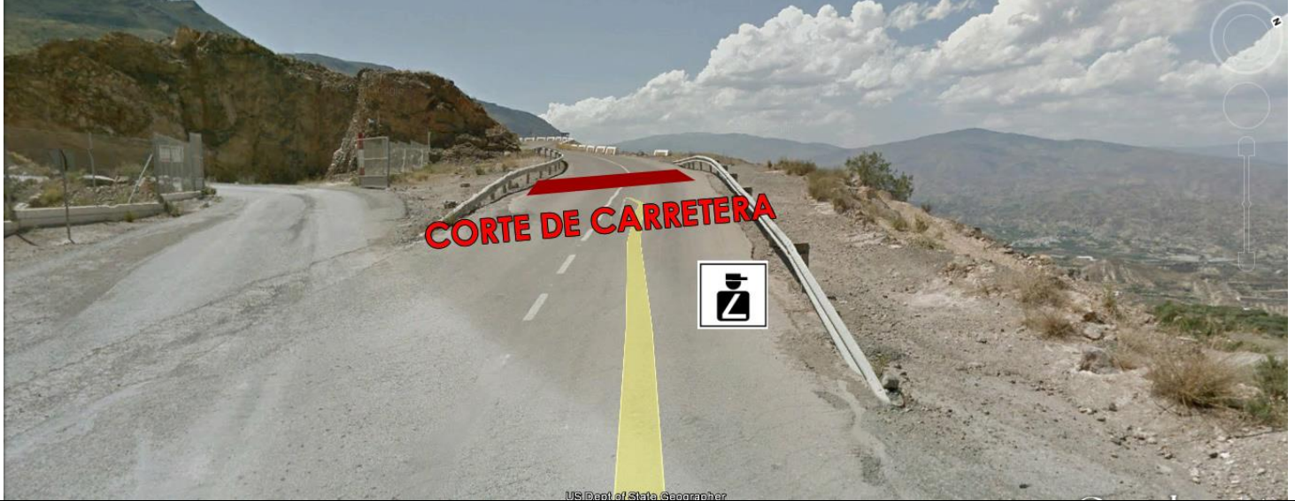
Carretera A-391 P.K. 24,8 Coordenadas: N 36°57'23.44" | O 2°35'46.05"
